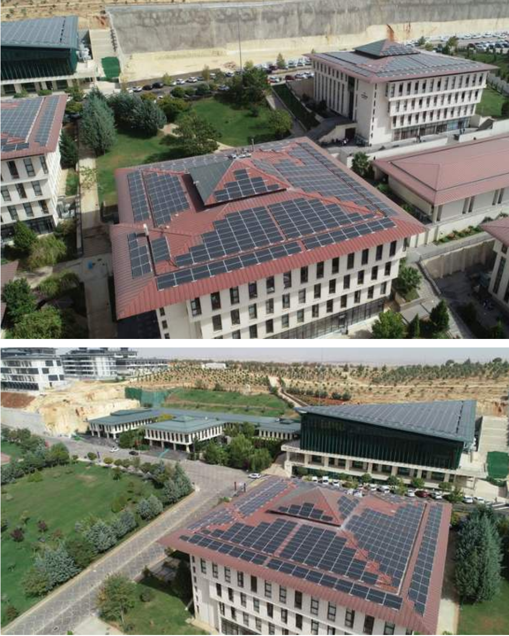
Şekil 7. Kampüs içerisinde yer alan çatı tipi güneş enerjisi sistemine ait görüntüler
